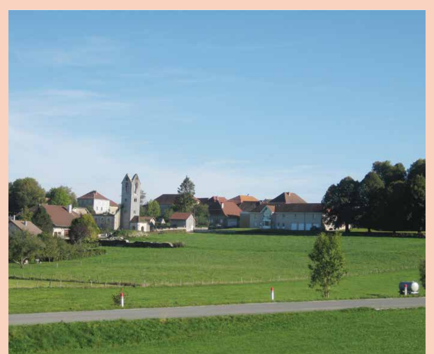
Figure 5 : Photo projet de lotissement ©CAUE 25
